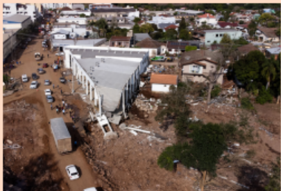
Fenômenos climáticos mais extremos como a chuva que deixou 5 mil mortos na Líbia e a passagem do ciclone pelo Rio Grande do Sul, que ocasionou 50 mortes e um rastro de destruição.
